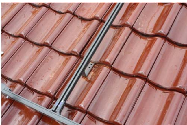
Figur 8. Stativ ferdig installert på taket.
