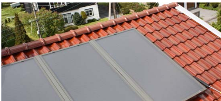
Figur 6. Tre plane solfangere monterert på taket.
